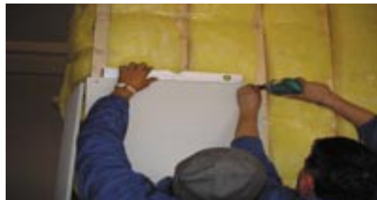
Das erste Panel muss lotrecht montiert werden. Befestigung mit einer Schraube, einrichten der Platte und befestigen.
