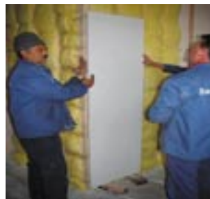
Ansetzen der HERZ Panele.
