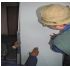
Das erste Panel muss lotrecht montiert werden. Befestigung mit einer Schraube, einrichten der Platte und befestigen.
