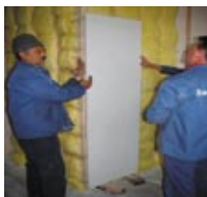
Ansetzen der Herz Panele
